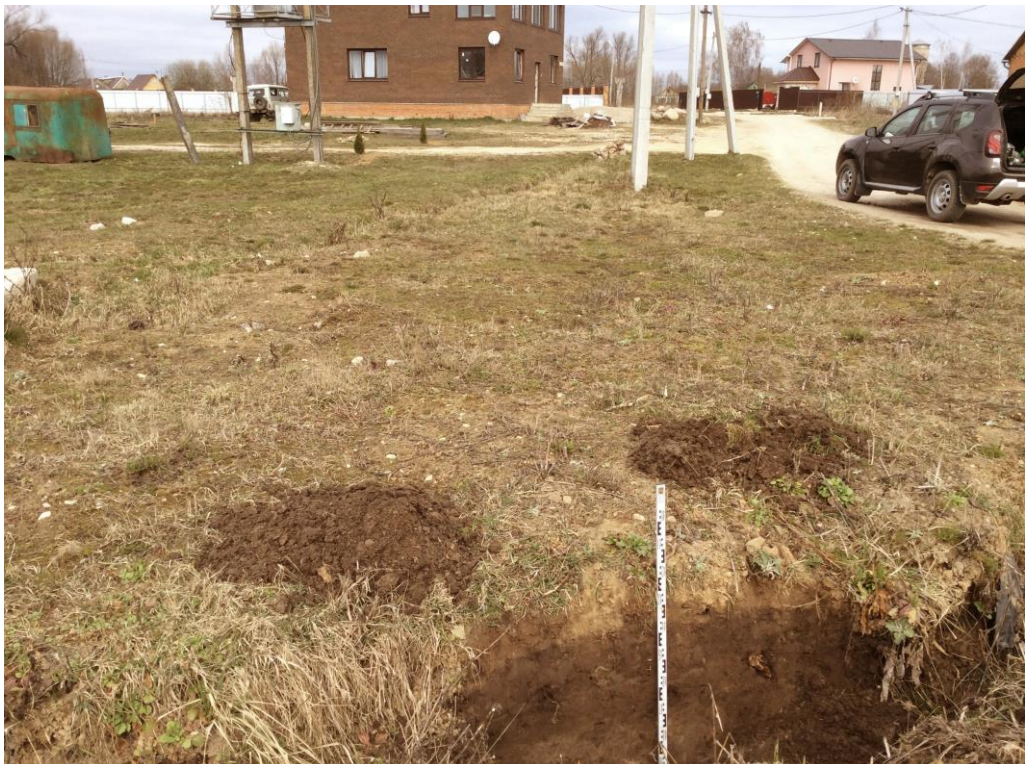
Рис. 164. Участок проведения археологических исследований на объекте: «Строительство хозяйственно-бытовой канализации южной части с. Перемышль, Перемышльского района Калужской области». Зачистка 3. Вид с юга.
