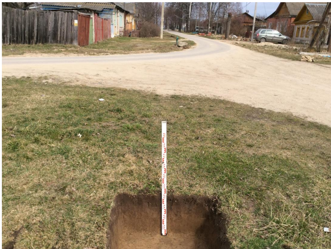
Рис. 59. Участок проведения археологических исследований на объекте: «Строительство хозяйственно-бытовой канализации южной части с. Перемышль, Перемышльского района Калужской области». Шурф 8. Вид с юга.
