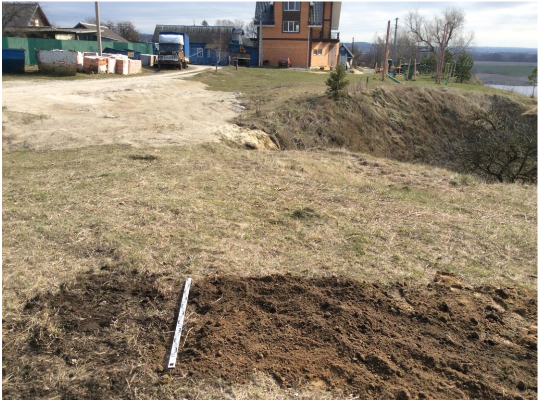
Рис. 31. Участок проведения археологических исследований на объекте: «Строительство хозяйственно-бытовой канализации южной части с. Перемышль, Перемышльского района Калужской области». Засыпанный шурф 2. Вид с запада.
