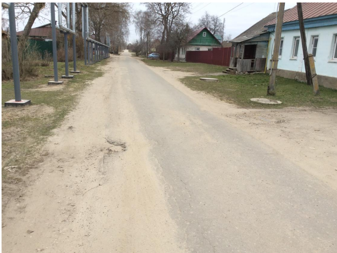
Рис. 18. Участок проведения археологических исследований на объекте: «Строительство хозяйственно-бытовой канализации южной части с. Перемышль, Перемышльского района Калужской области». Вид с востока.
