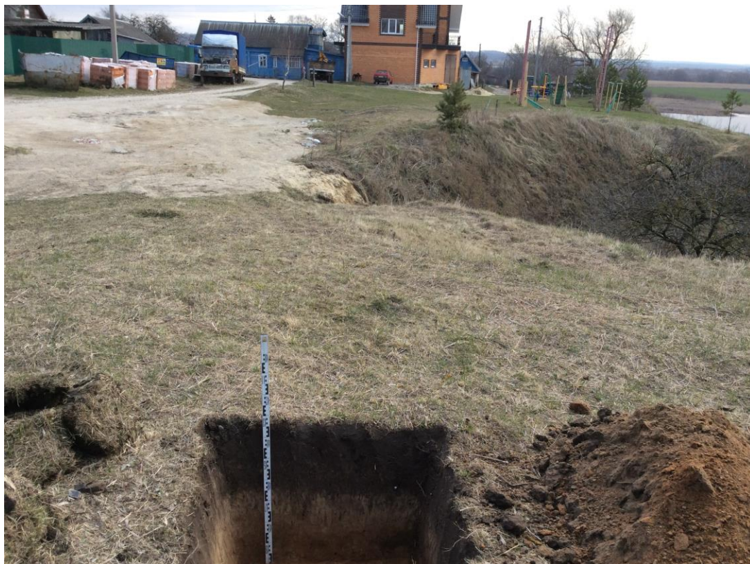
Рис. 29. Участок проведения археологических исследований на объекте: «Строительство хозяйственно-бытовой канализации южной части с. Перемышль, Перемышльского района Калужской области». Шурф 2. Вид с запада.
