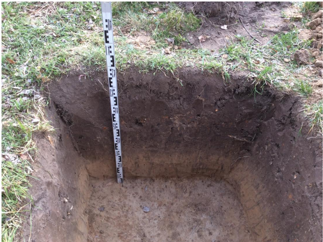
Рис. 156. Участок проведения археологических исследований на объекте: «Строительство хозяйственно-бытовой канализации южной части с. Перемышль, Перемышльского района Калужской области». Шурф 18. Вид с севера.
