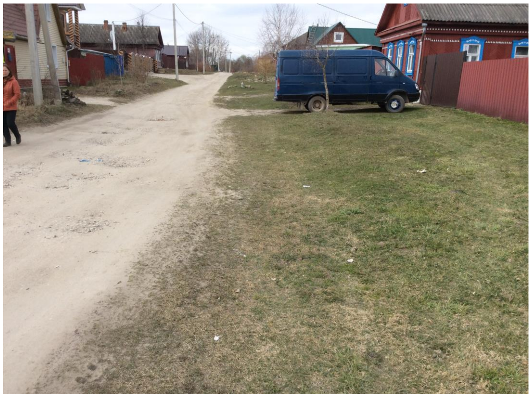
Рис. 14. Участок проведения археологических исследований на объекте: «Строительство хозяйственно-бытовой канализации южной части с. Перемышль, Перемышльского района Калужской области». Вид с востока.
